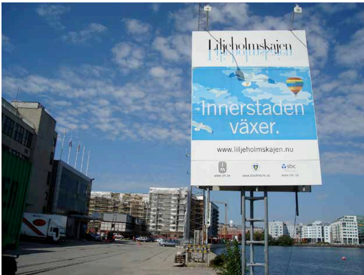
Liljeholmskajen under byggnation. Foto: Moa Tunström
